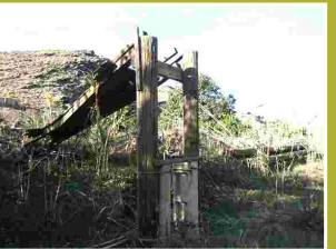
Antigua pasarela para cruzar el río
